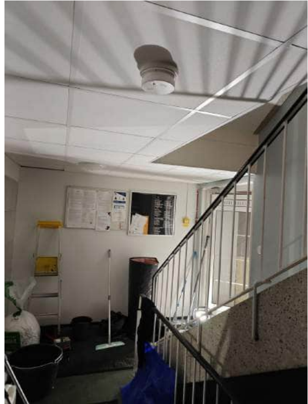
P krs. Puhdistus käynnissä.
