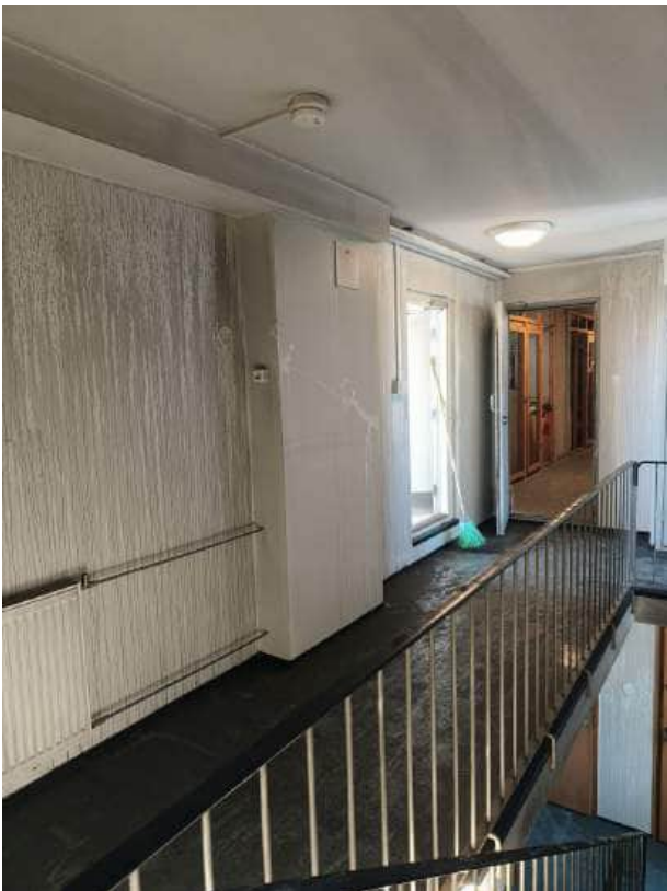
Ullakko yleiset porrashuone.
