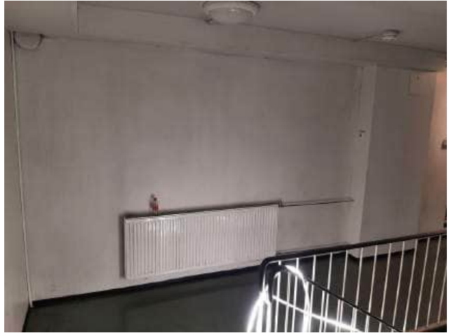
8krs Yleiskuvia rappukäytävästä siivouksen jälkeen
