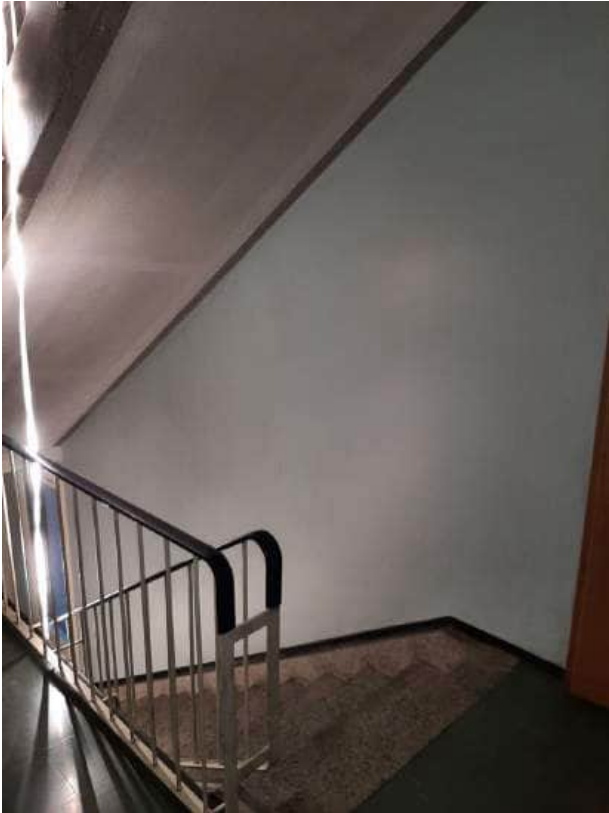
7krk rappukäytävän siivouksen jälkeen
