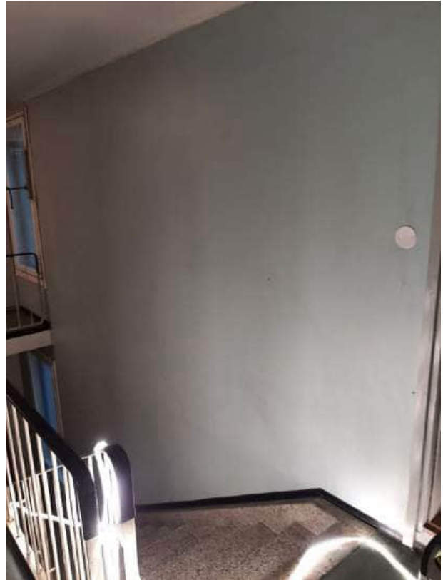
8kr's Yleiskuvia rappukäytävästä siivouksen jälkeen
