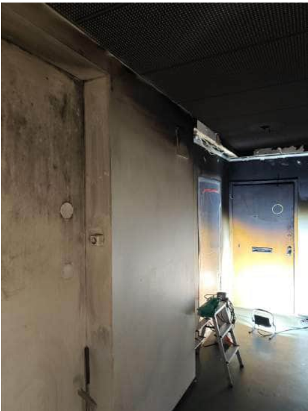
1 krs. Puhdistus käynnissä.
