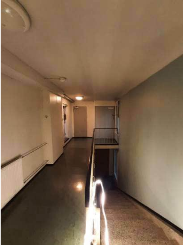
8krs Yleiskuvia rappukäytävästä siivouksen jälkeen
