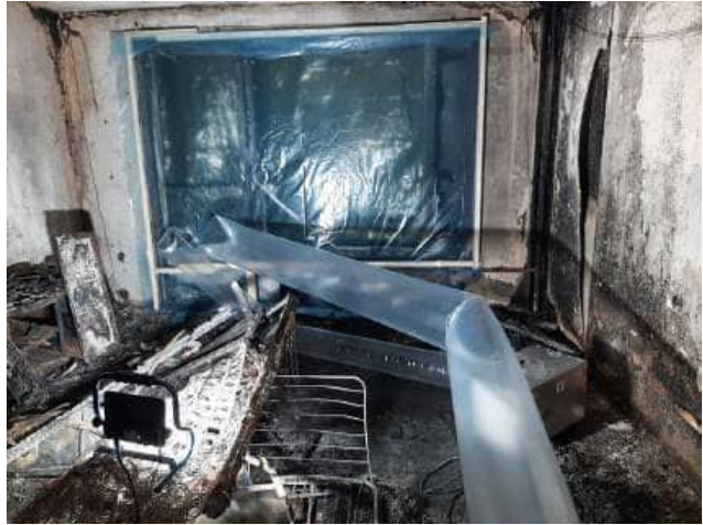
as4 ikkuna ja ranskalainen parveke muovitettu alipaineistusta varten
