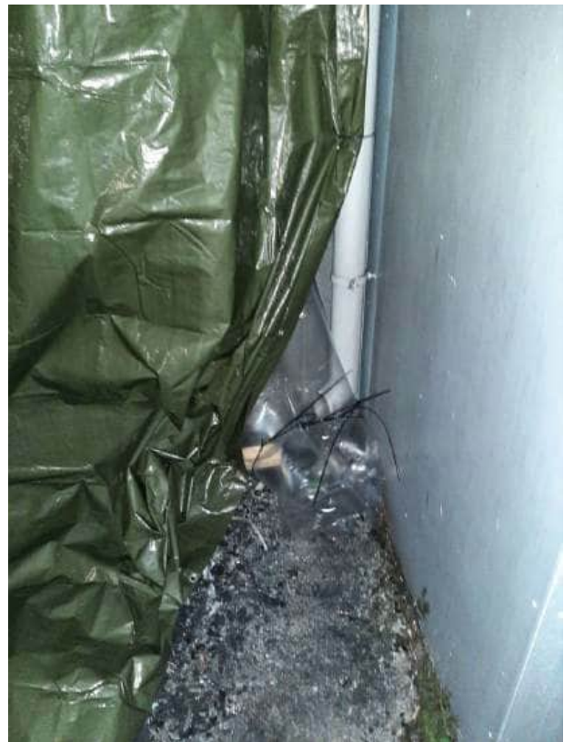
Alipaineistimien poistot tuotu pressun alta takapihalle
