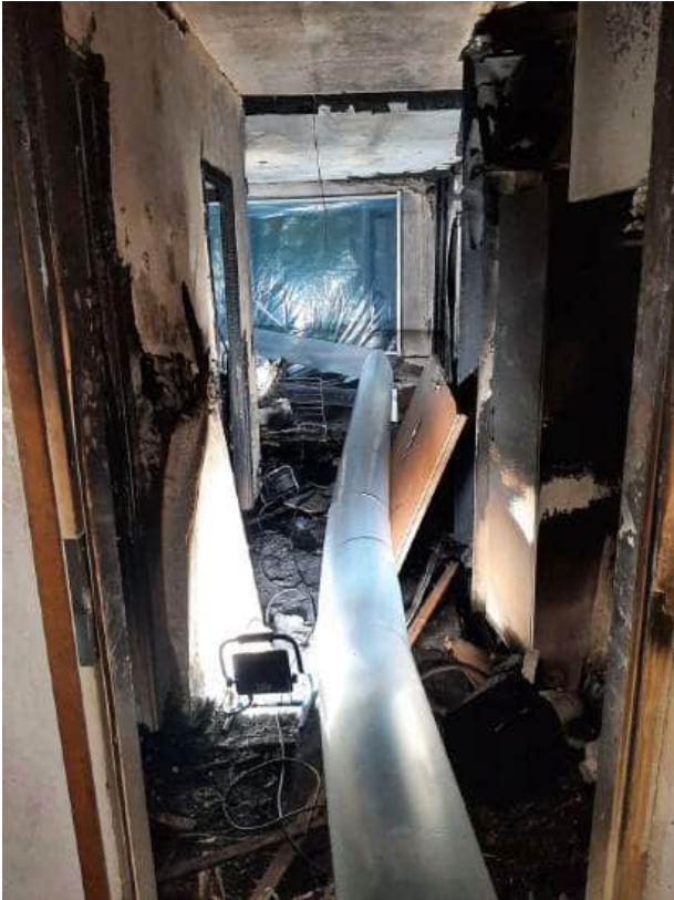
as4 ikkuna ja ranskalainen parveke muovitettu alipaineistusta varten
