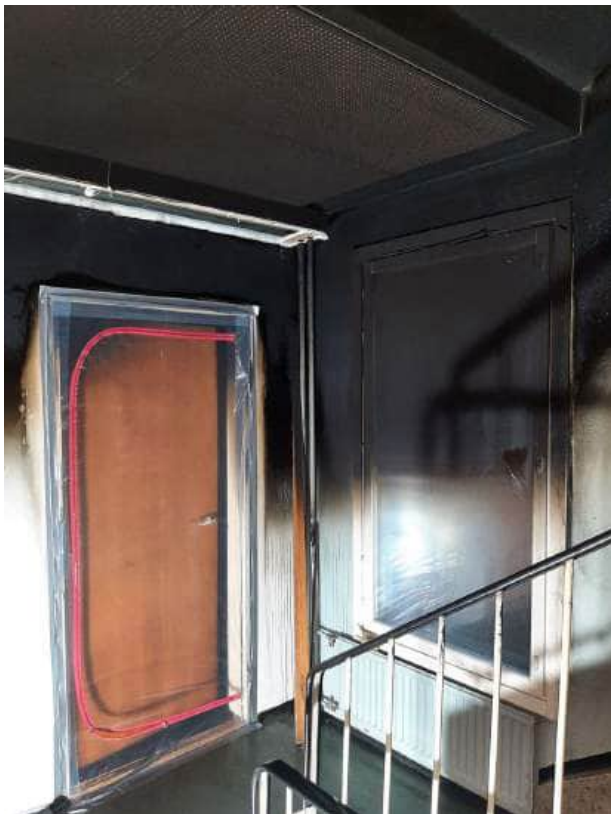
1, as6 ja rappukäytävän ikkuna
