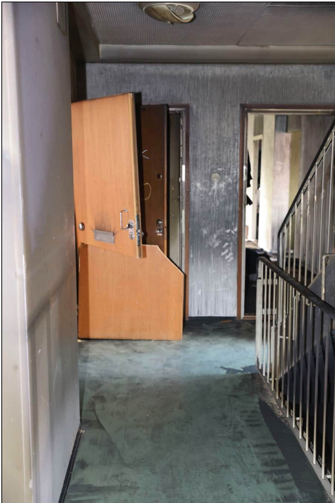
5. Kuva toisesta kerroksesta.
