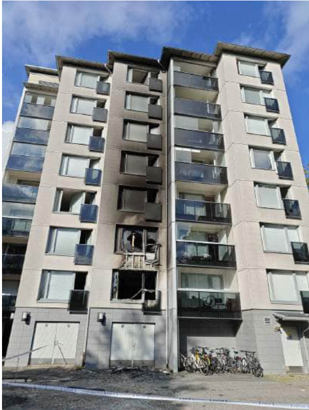
Asunto A4 autotallin päällä.
