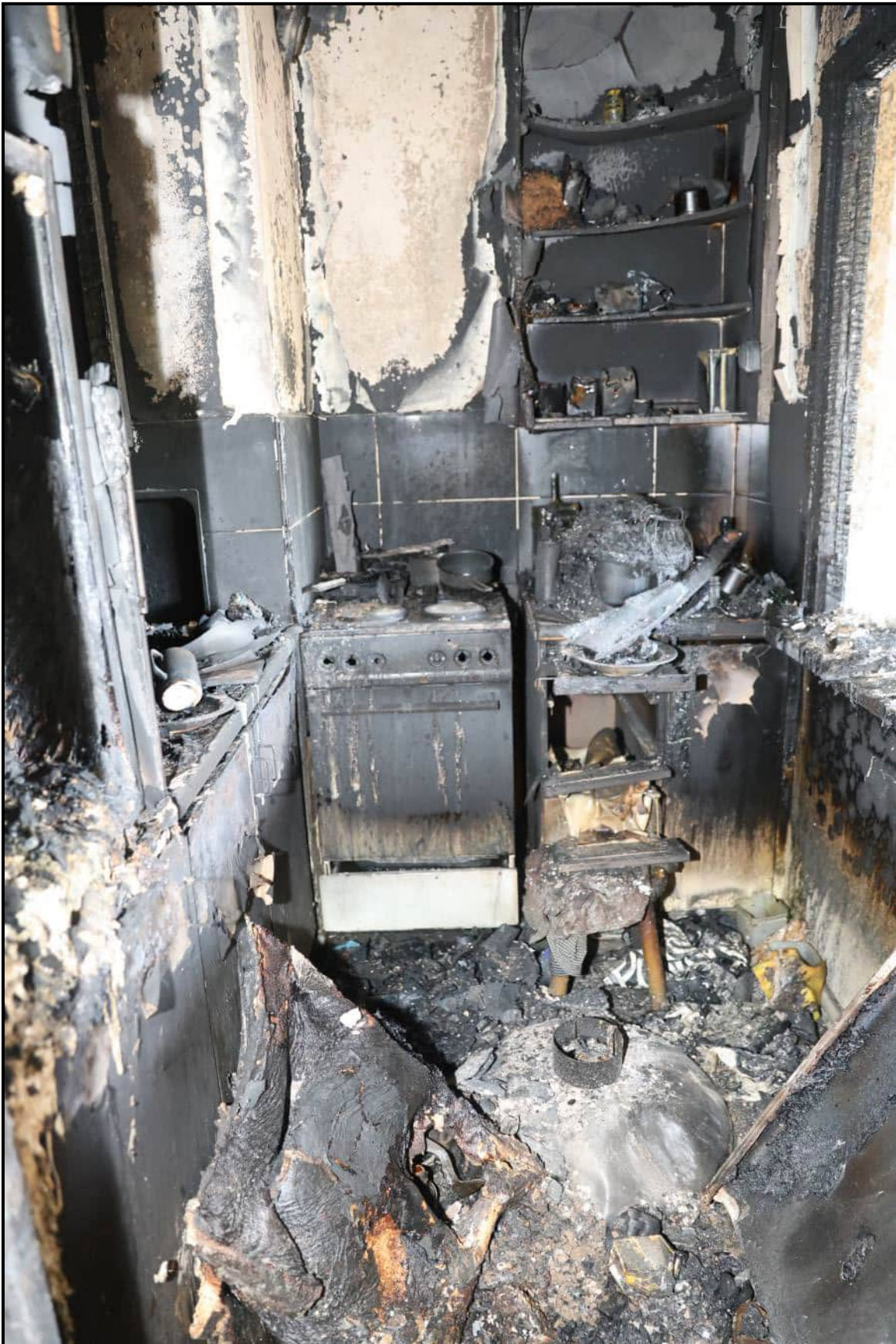
25. Asunnon keittokomero, kuvattuna oviaukosta, takana on eteinen (Kts tarkempi sijainti kuvassa 8). Väli-seinän aukko olohuoneeseen on kuvassa oikealla puolella.
