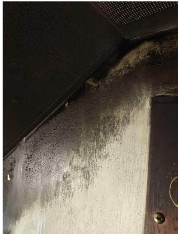
2 krs. Seinäpiinoite rakkuloilla.
