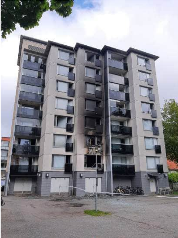
Talo takapihan puolelta, as 4 ja as 10 ikkunat ja rans. parvekkeet rikkoutuneet.
