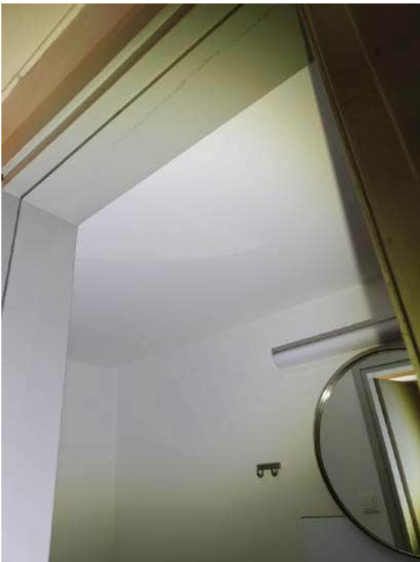
Ullakko yleiset tilat wc katto
