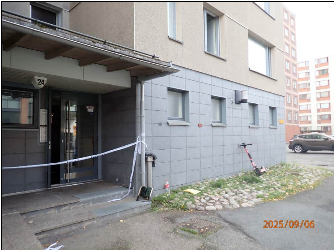
3. Sisäänkäynti Kullervonkadun puolelta. Parkkipaikka jää rakennuksen taakse.
