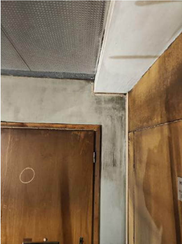
1 krs. Puhdistus käynnissä.
