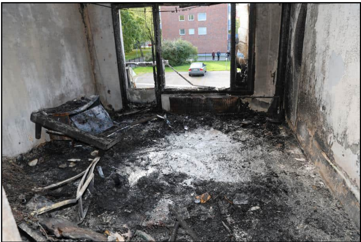
20. Edessä asunnon olohuoneen ikkuna. Takana eteinen ja keittiö.
