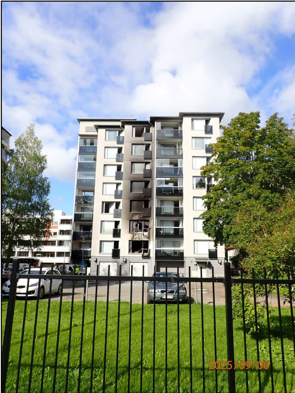
2. Yleiskuva kerrostalosta. Kullervonkatu sijaitsee kerrostalon takana, jossa myös pääsisäänkäynti rappukäytävään.
