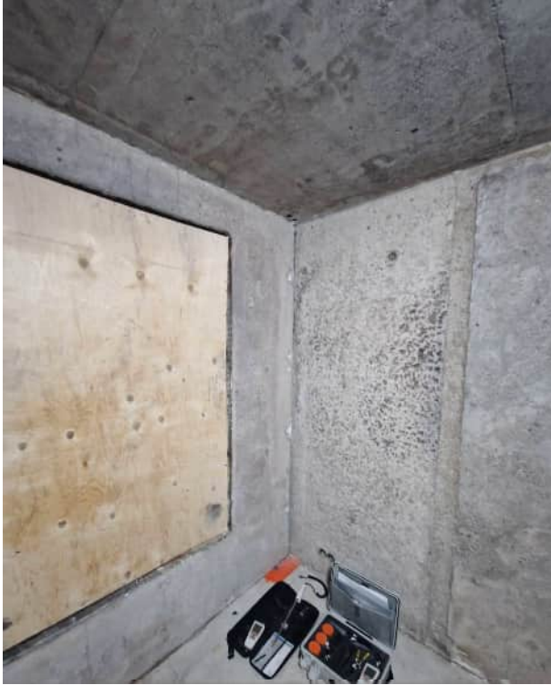
Kuva 1. Huoneisto 4, olohuone, patterilinja purettu.
