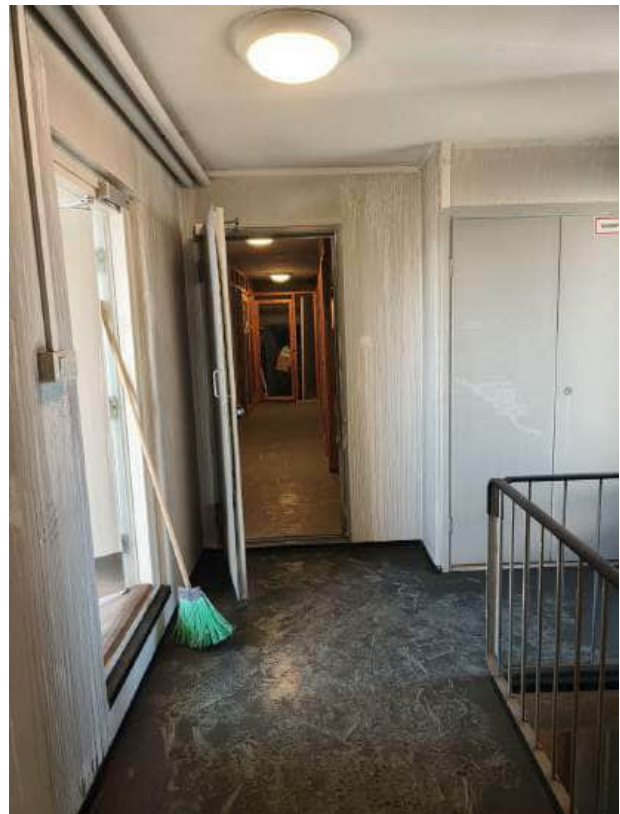
Ullakko yleiset porrashuone.
