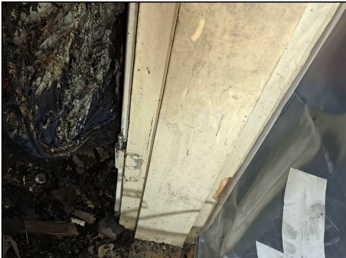
14. kuva ovenkarmista, jossa nähtävissä väliooven alaosan sarana/saranatappi ja ulko-oven alaosan saranatappin kohta.
