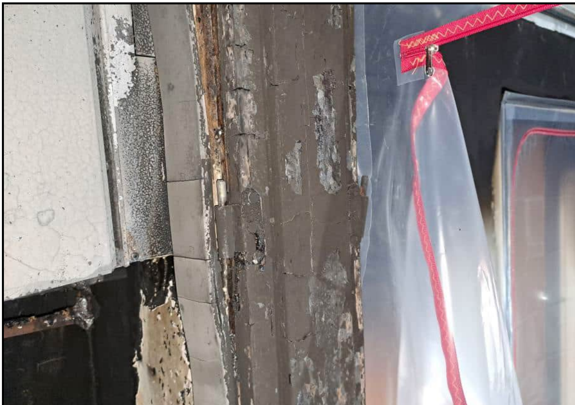
12. Kuvassa ovenkarmi, jossa nähtävissä väliooven sekä ulko-oven ylimmät saranatapid/saranat.
