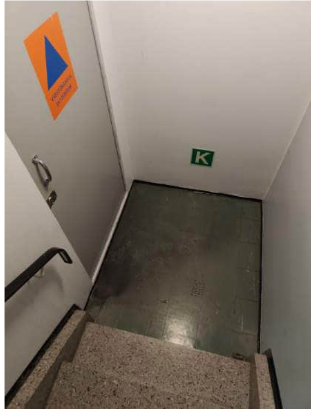
U käynti vss lämmönjako yms. Kellaritiloissa ei vuoto tai palojälkiä
