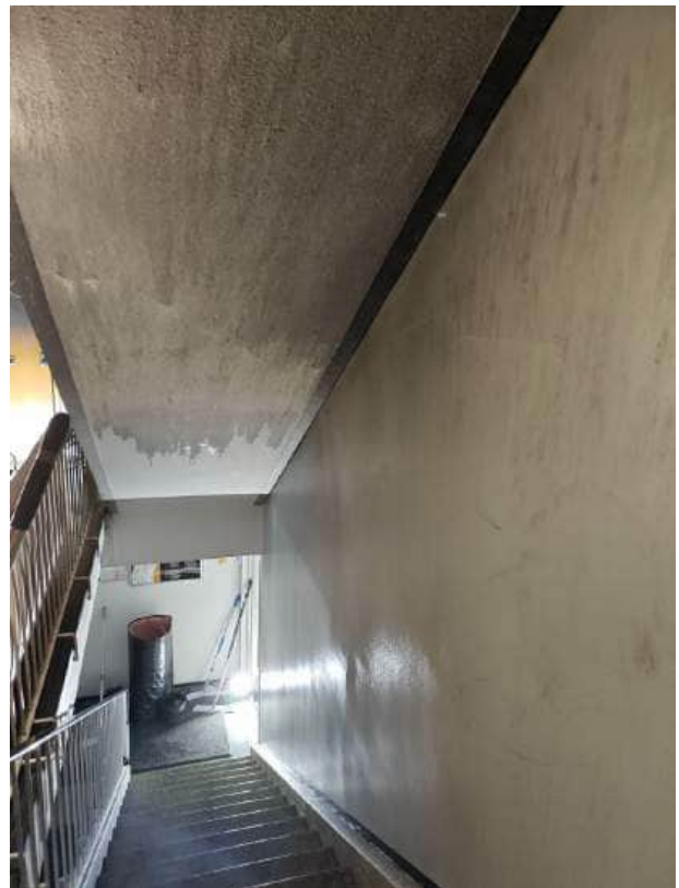
1 krs. Puhdistus käynnissä.
