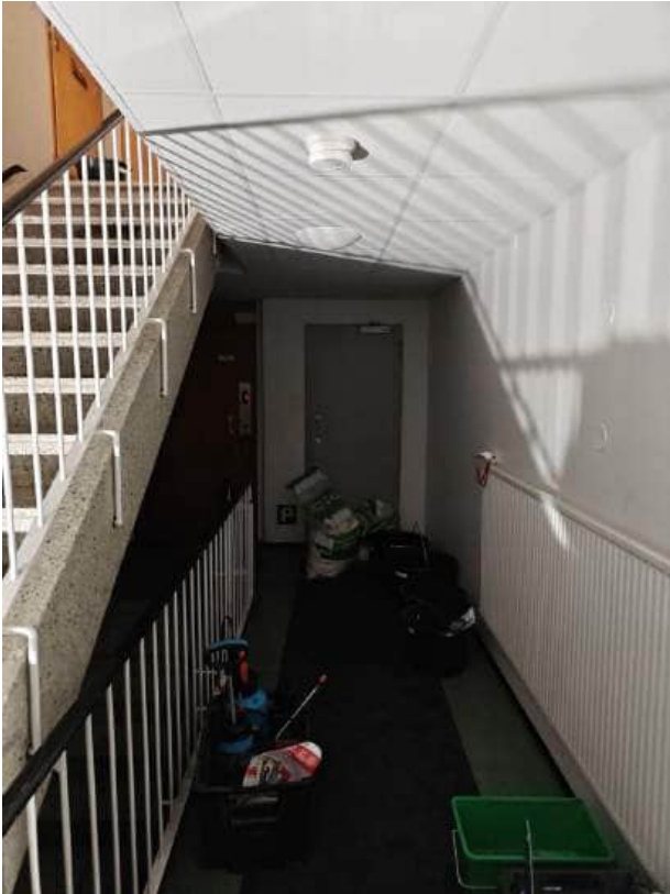
P krs. Puhdistus käynnissä.
