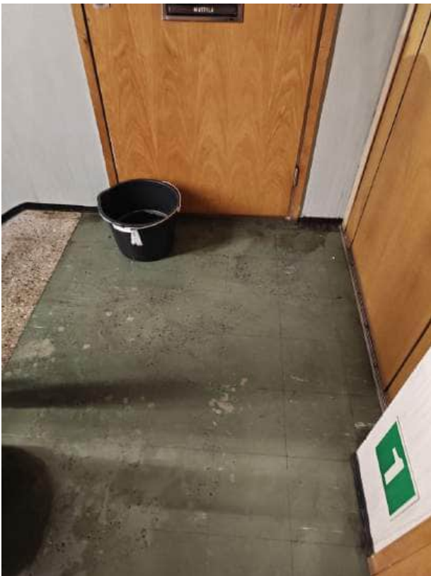
1 krs. Puhdistus käynnissä.
