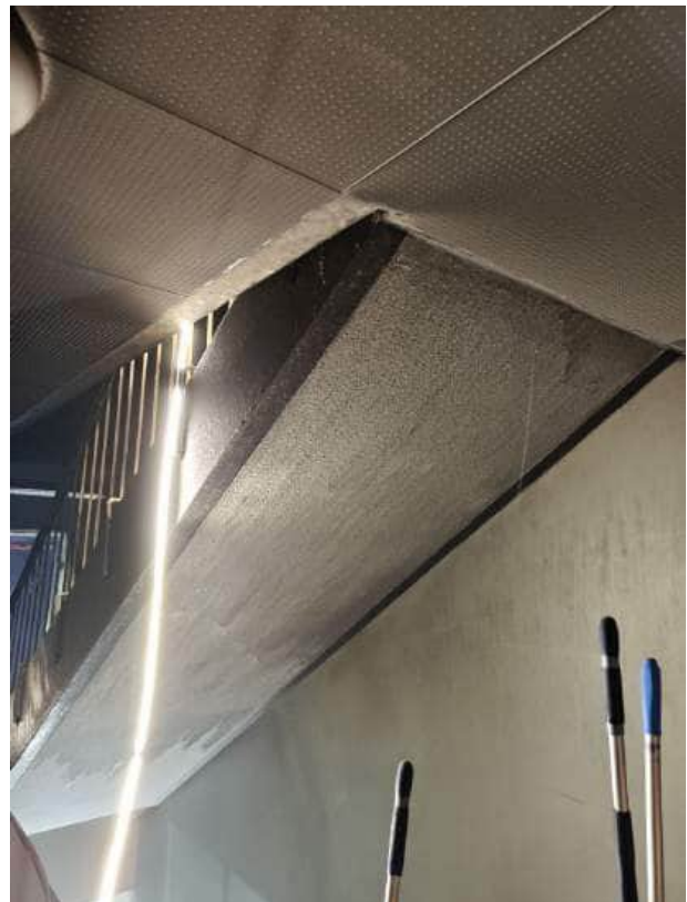
1 krs. Puhdistus käynnissä.
