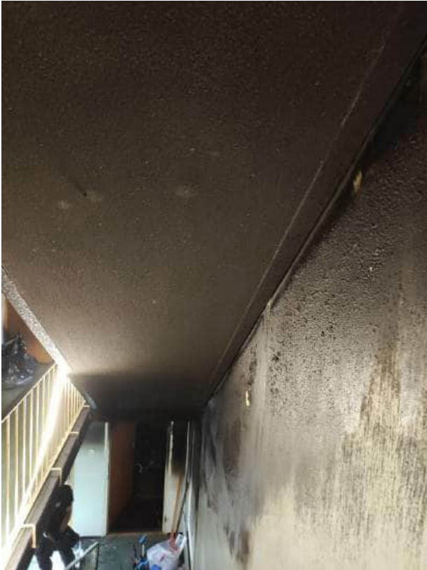
2 krs. Seinä ja porraselentti rakkuloilla.
