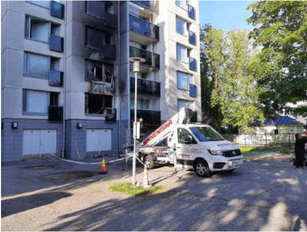
Nostin tilattu, jotta rikkoutuneet ikkuna-aukot saadaan pressulla umpeen
