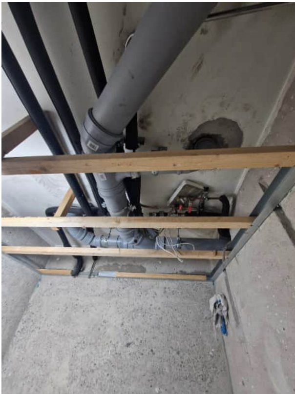
Kuva 3. Huoneisto 4, kph katto avattu, putkieristeitä purettu.
