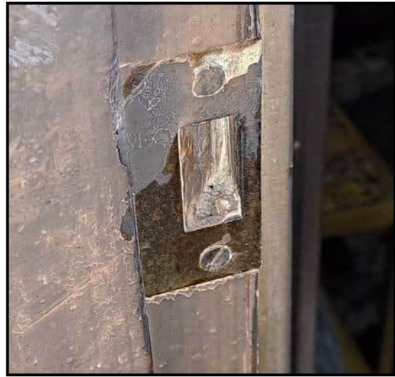
16. Kuvat ovenkarmin vastaraudoista. Alapuolella suurennetut kuvat ulko-oven (vasemmalla) ja välioiven (oikealla) vastaraudoista.
