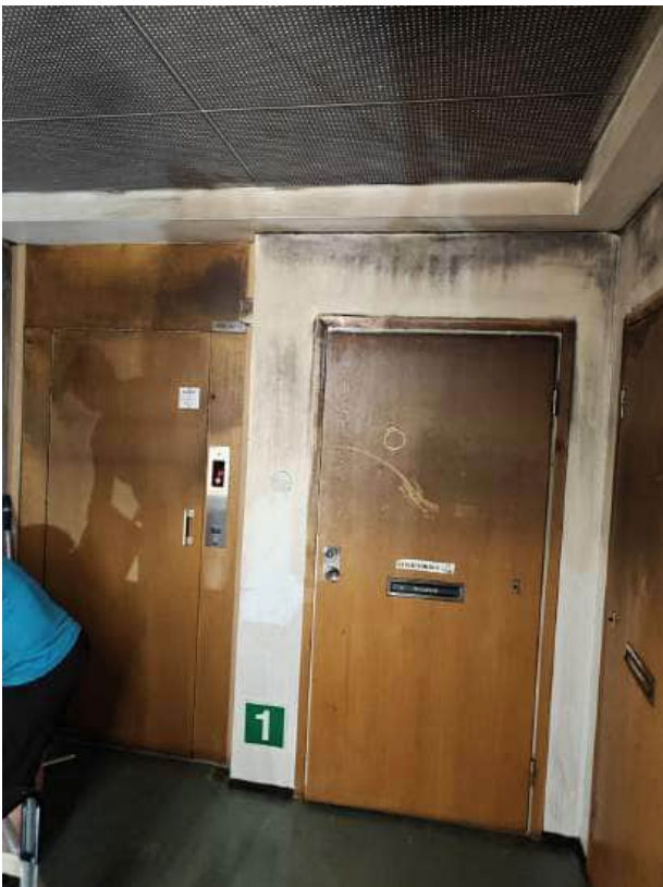
1 krs. Puhdistus käynnissä.
