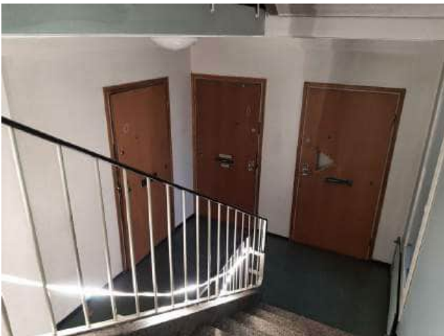
6krk rappukäytävän siivouksen jälkeen
