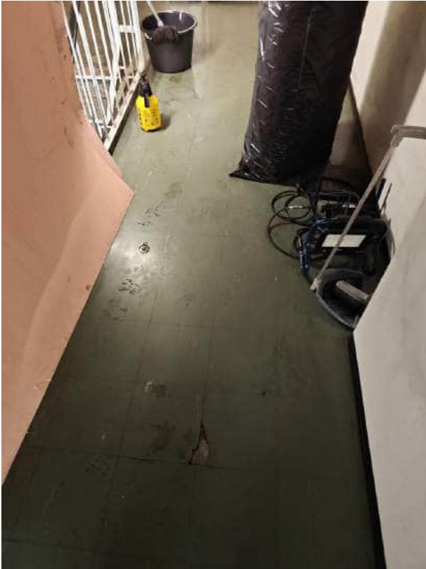
1 krs. Puhdistus käynnissä.
