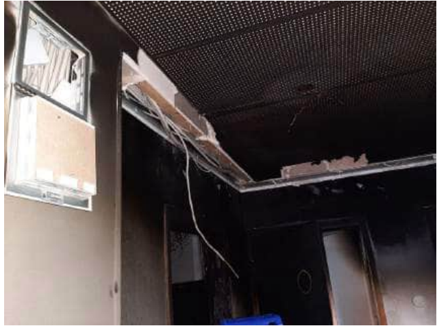
Kipsilevyiset sähkökotelot purettu sähköasentajan tarkastusta varten
