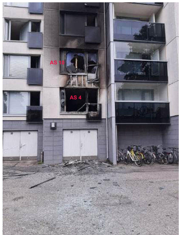
Autotallin päällä asunto 4 ja sen yläpuolella asunto 10
