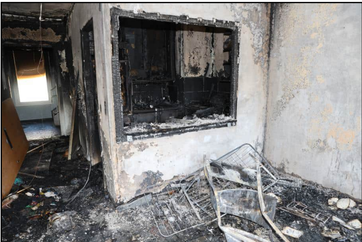
18. Asunto kuvattu olohuoneen suunnalta keittiöön. Keittokomeron väliseinässä on rakenteisiin kuuluva ikkunaton aukko.
