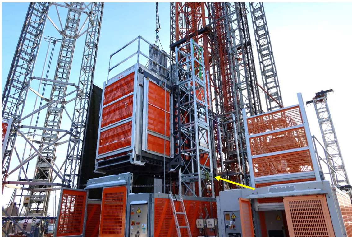
Figur 1. Den uppbyggda masten och hissen. Pilen visar skarven där bultarna/skruvarna lossades.
