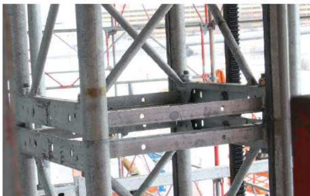
Figur 28. Fyra skruvförband i mastskarven håller ihop konstruktionen.
