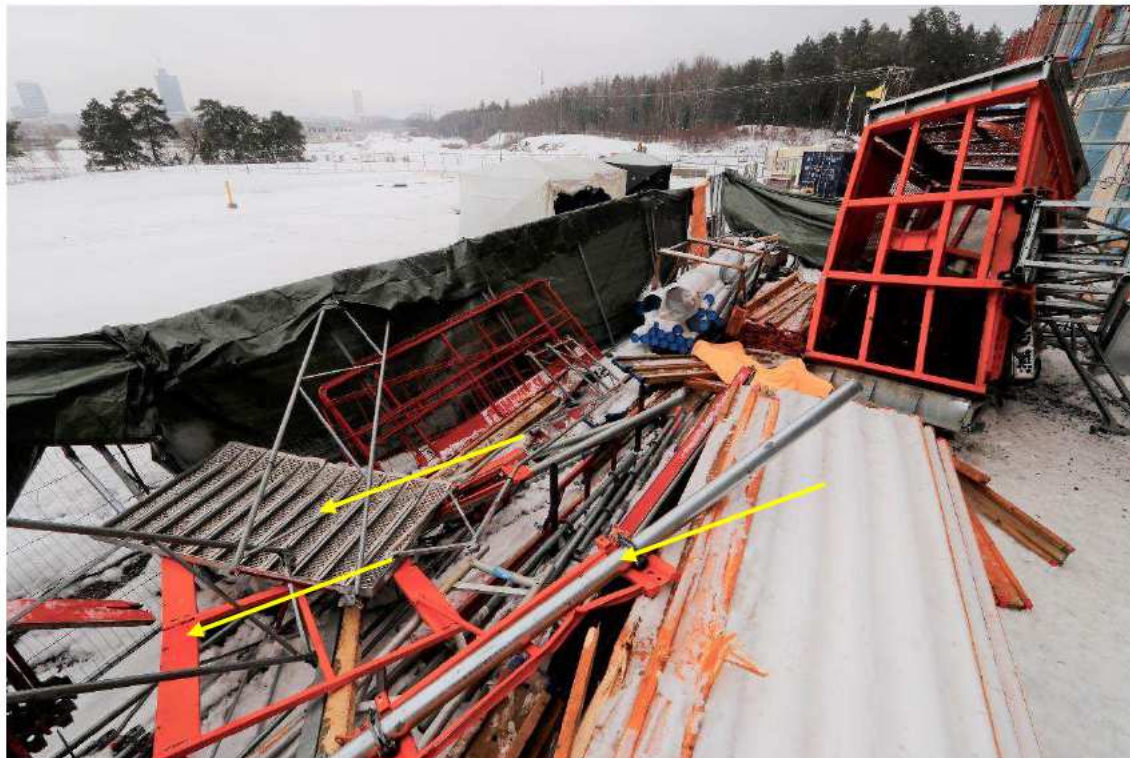
Figur 23. De gula pilarna markerar vertikallrör, grind och brygga från plan 9.
