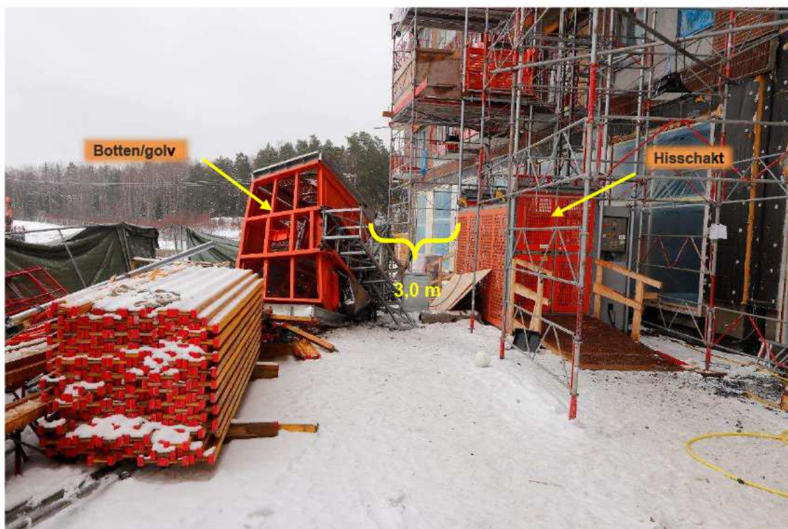
Figur 15. Hisskorgen ligger ca 3 m från hisschaktet.
