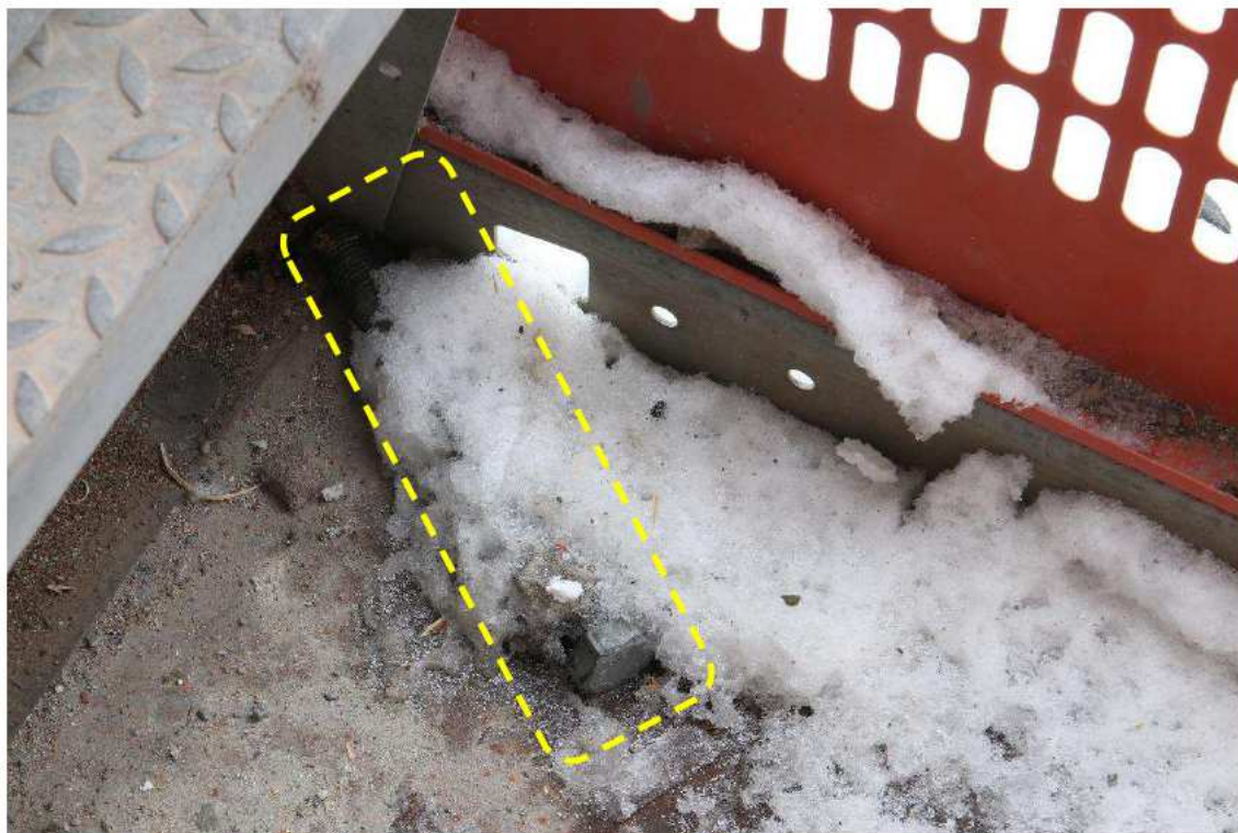
Figur 34. Den gula streckade markeringen visar den fastfrusna skruven (G005).
