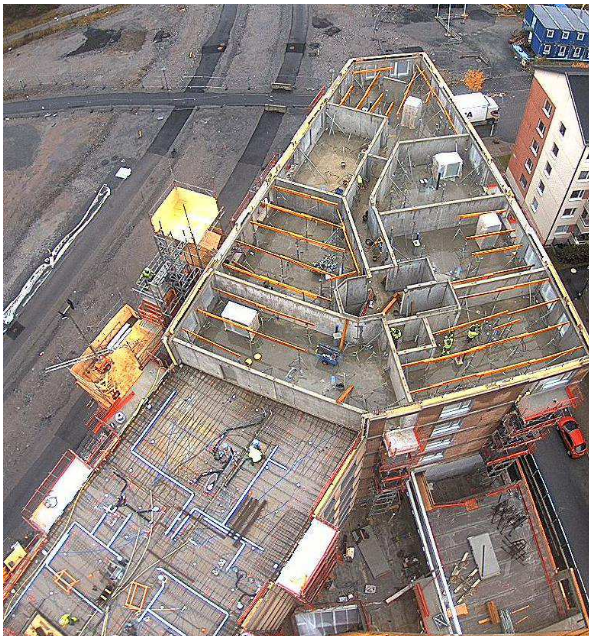
Bild tagen av tornkrankameran den 1 november 2023 kl. 08.30
