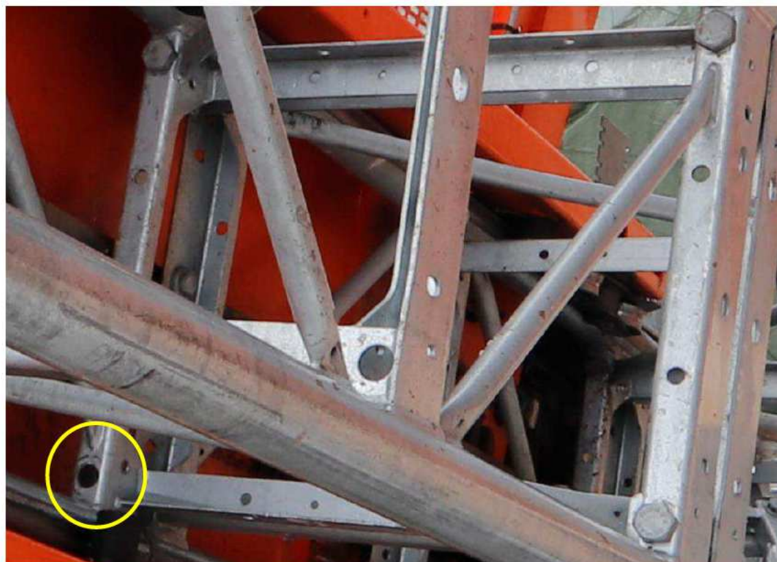
Figur 17. Den gula cirkeln visar fästpunkten där skruvförband saknas.
