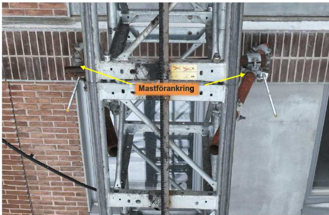
Figur 32. Mastförankring i fasadväggen i höjd med plan fem.
