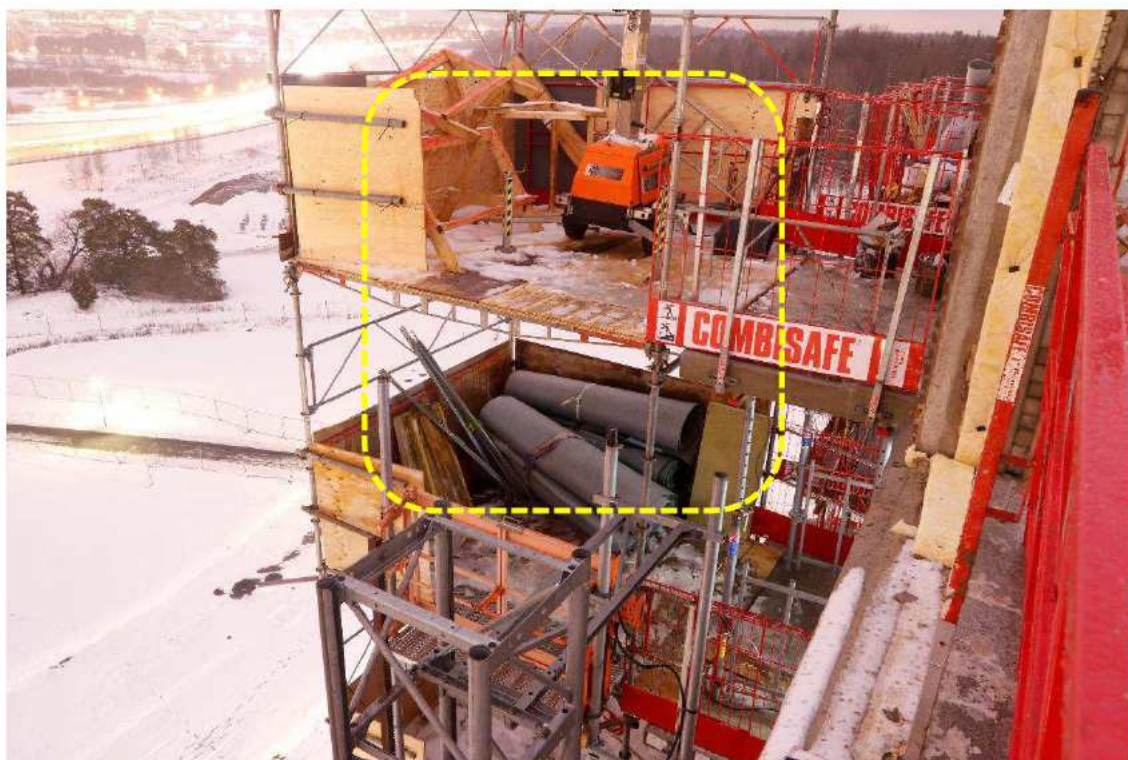
Figur 24. I den gula streckade markeringen saknas stannplansdörr, brygga och vertikallrör.
