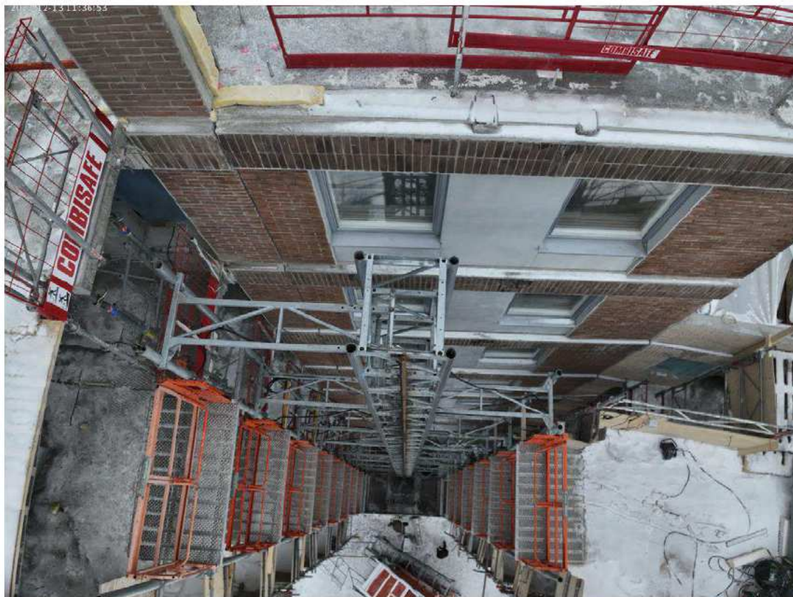
Figur 31. Hissmastens övre del fotograferad med UAS.
