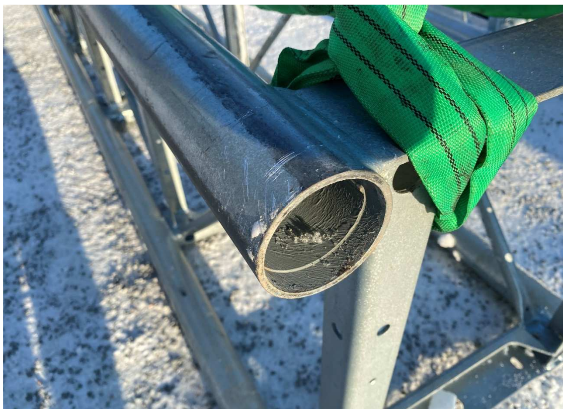
Figur 6. Närbild på en av mastsektionens infästningar.
