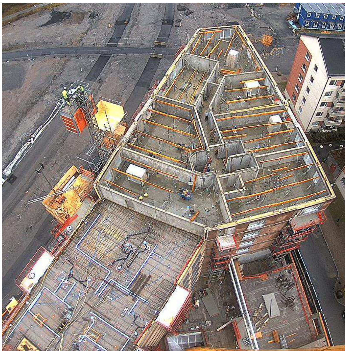
Bild tagen av tornkrankameran den 1 november 2023 kl. 09.00
