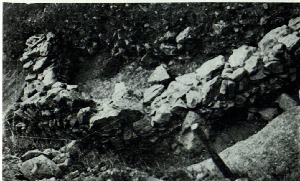
Predloka pri Crnem, Koper, sl. 1. Polkružni zid v sondi II; sl. 2. Lok. »Pjaca«, opšti izgled
