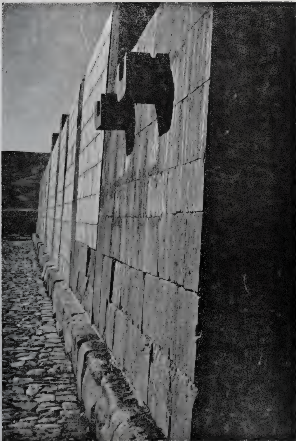
53. La llamada pared balconera o Chunchukala, restaurada (1972).
