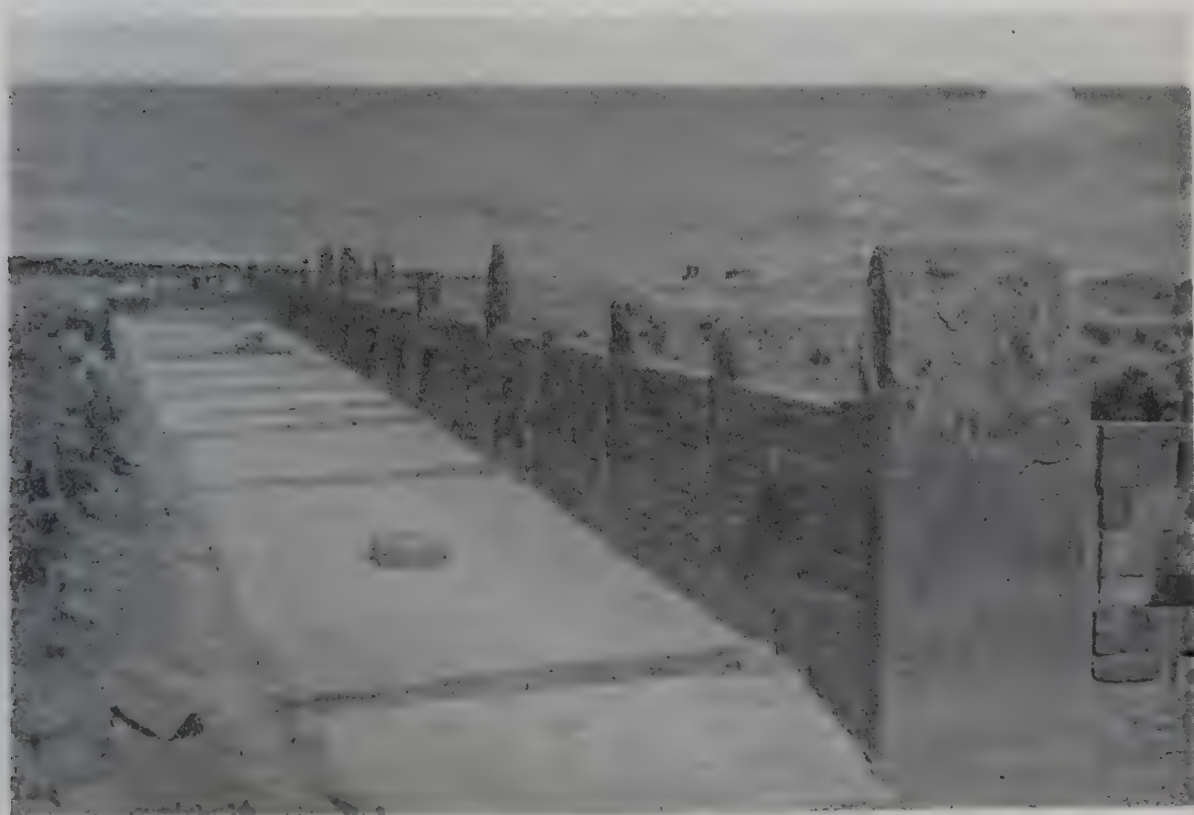
50. Muro sur de Kalasasaya, con su sistema de canales de drenaje.
