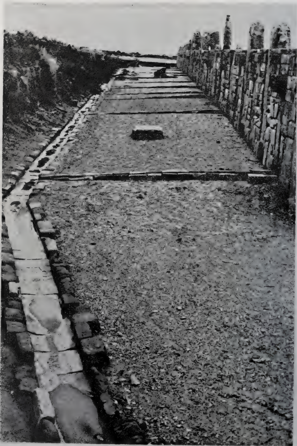
54. El muro sur de Kalasasaya con su sistema de canales para facilitar el drenaje.
