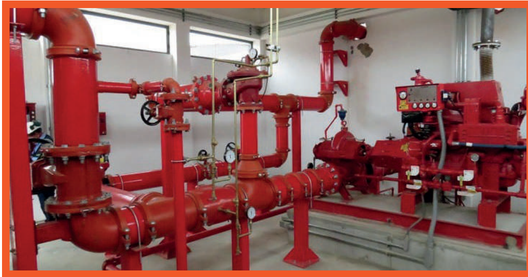
INSTALACIÓN DE SISTEMA DE AGUA CONTRA INCENDIO EN CUARTO DE BOMBAS – BOMBA PRINCIPAL Y JOCKEY
