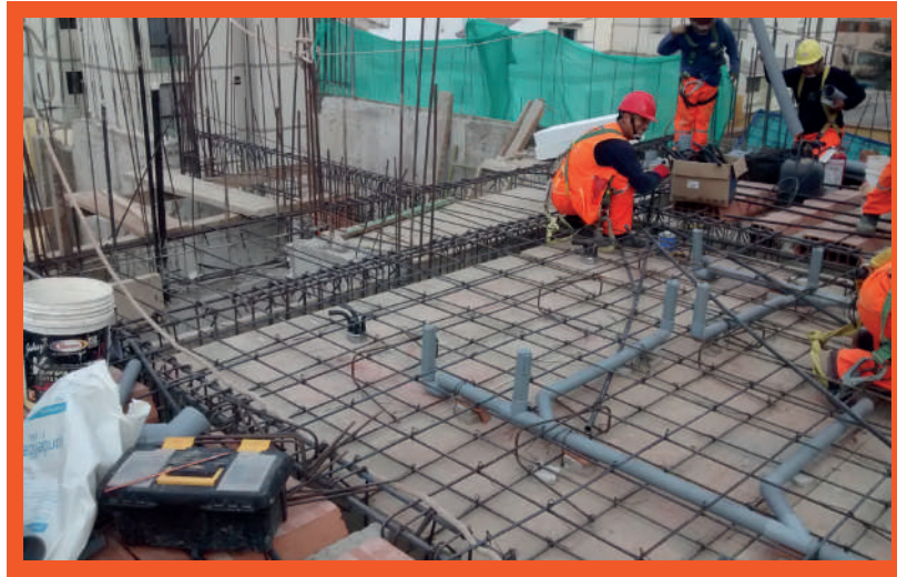
REDES EMPOTRADAS EN LOSA DE DESAGÜE
