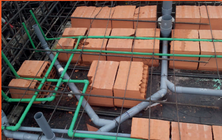
REDES EMPOTRADAS DE AGUA PPR Y DESAGÜE PVC EN LOSA
