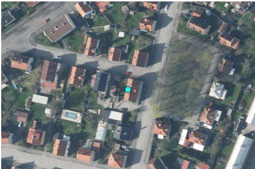
Figur 2. Översiktsbild över fastigheten på Viktoriagatan 19. Ingången till trapphuset är markerad med turkos prick. Flygfoto hämtat från Poliskarta Web 2025-10-21.
