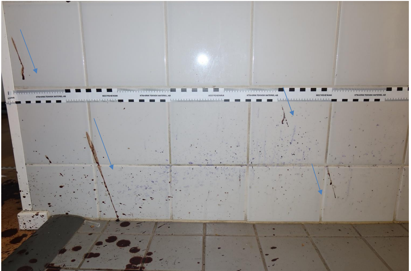
Kuva 13. Kuva wc:n oviaukolta katsottaessa vasemman puoleisen seinän alaosan jäljistä.
