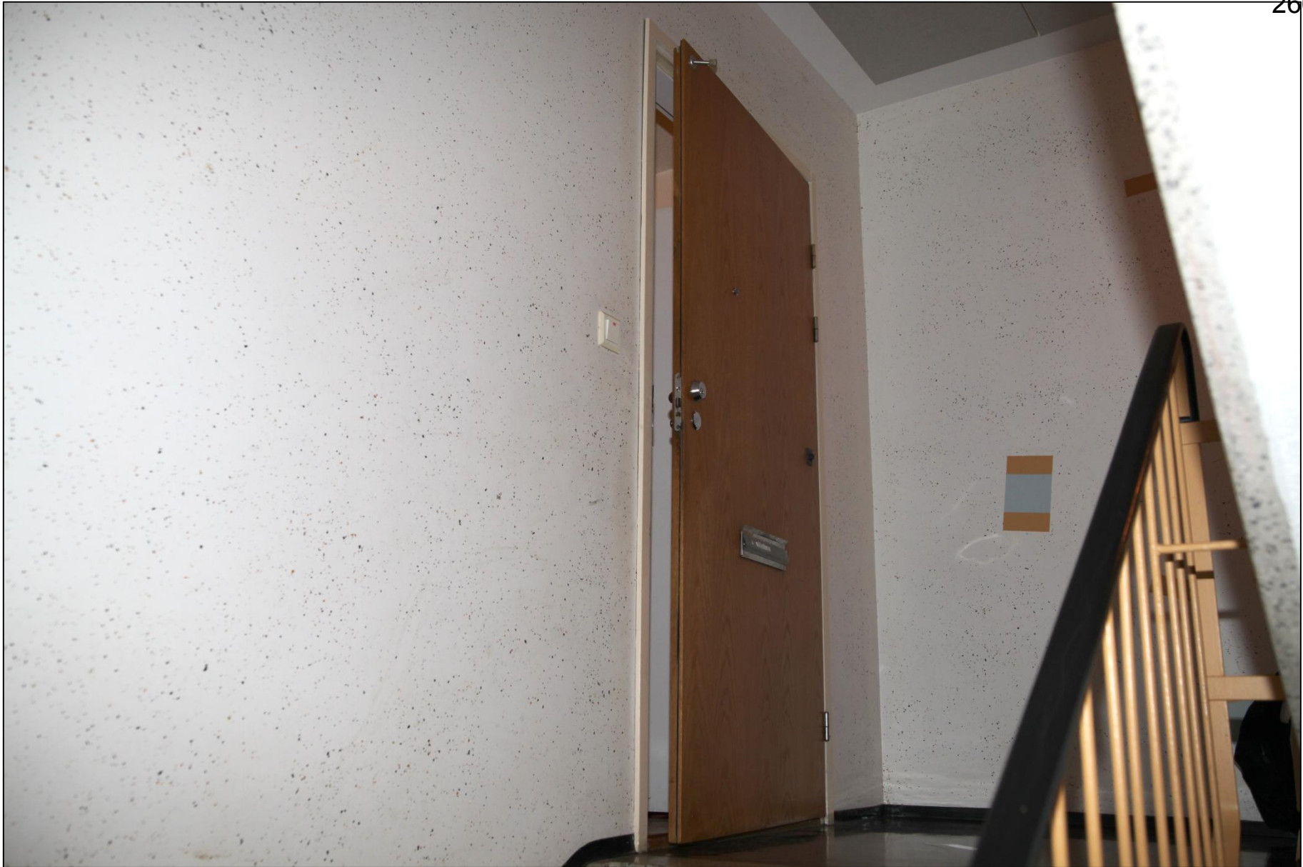
KUVA 4. Huoneiston A 4 ulko-ovi rappukäytävän ensimmäisen ja toisen kerroksen väliseltä tasanteelta kuvattuna.
