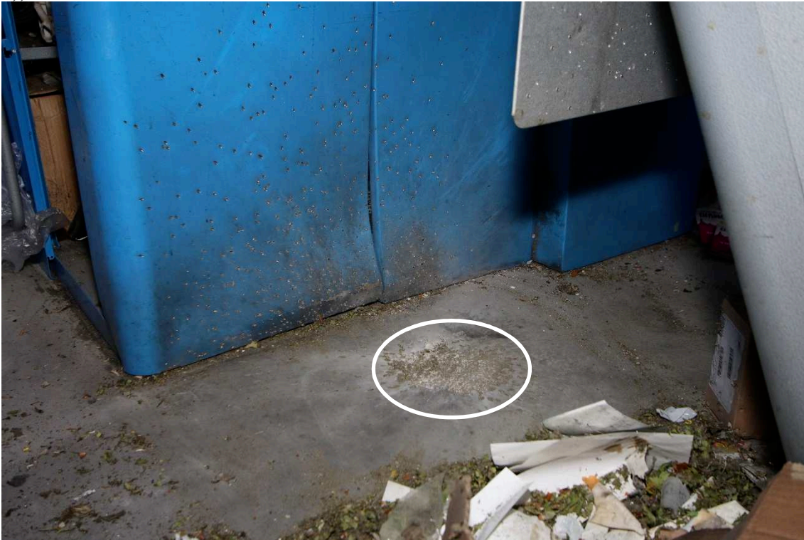
Figur 12: Golvet under den trasiga packhyllan efter att NBS rensat ytan. Placering av krevadgrop markerad med en vit ring.
