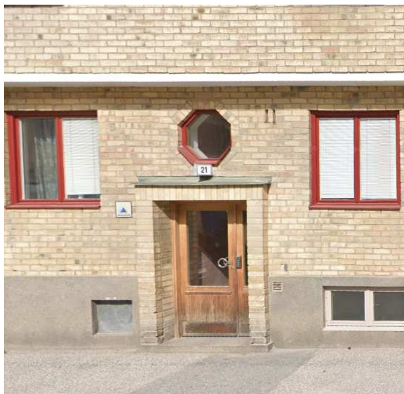
Porten till Hjortstoprsvägen 21 sett från gatan
