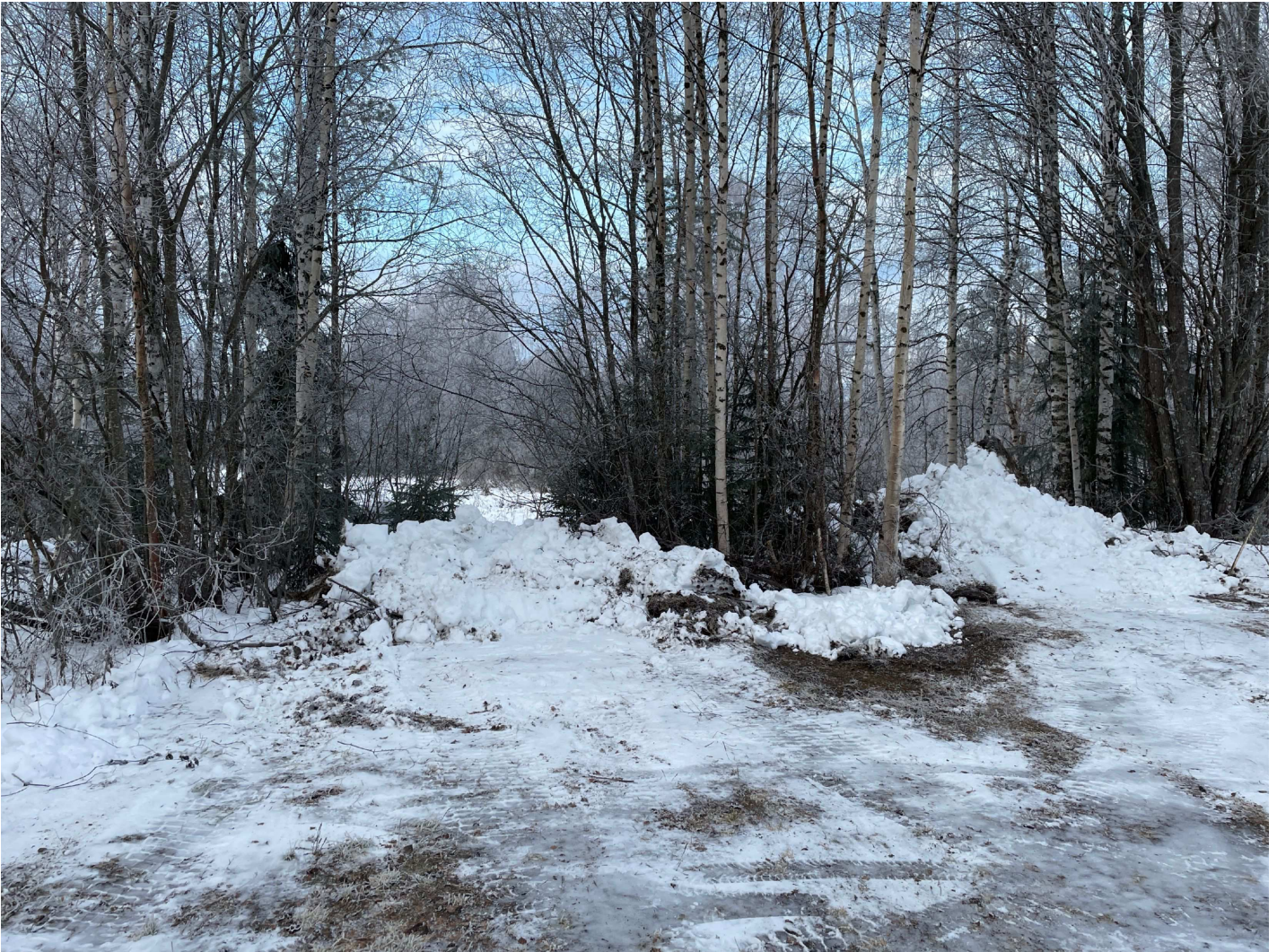
1. Snövall vid ställverket där Alex gått över snövallen.
